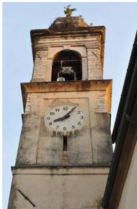
Il campanile della Chiesa di Pastrengo
